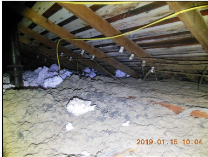
Uneven insulation
